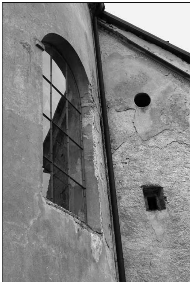
Zed' staré zákristie a zed' presbytáře, stav v roce 2011. Foto J. Krejčová.
